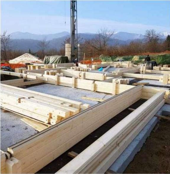
Le case prefabbricate in travi vengono assemblate a partire da un sistema costruttivo in travi (indicato anche con il termine tedesco Blockhaus), che consiste in elementi lineari di legno di conifera disposti orizzontalmente e sovrapposti tra di loro fino a formare una parete in legno.
